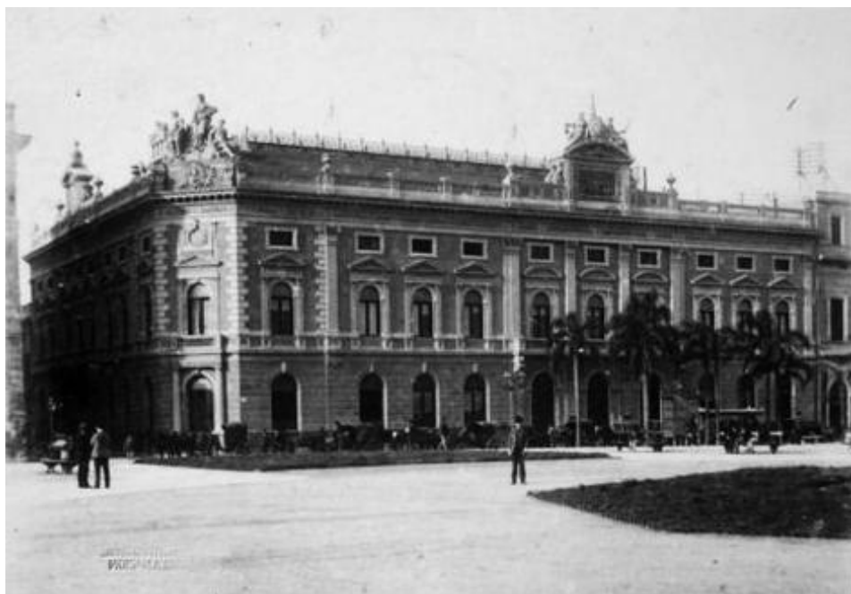
Figura n° 6. Vista del antiguo edificio del Banco Nacional, Buenos Aires, ca. 1890. Fuente: Archivo General de la Nación.
