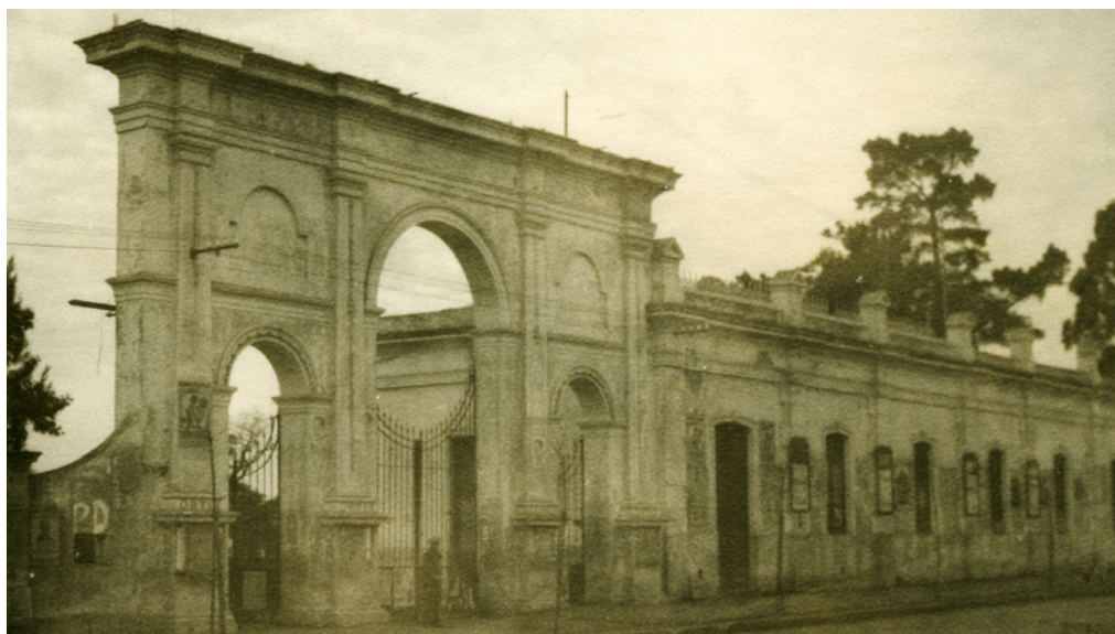
Vista de la fachada (detalle) de las Ferias Francas con inscripciones políticas, meses antes de ser demolida para la construcción del edificio de la Escuela Normal, Tandil, Foto Ros, ca. 1942. Colección familia Ros. Fuente: CeGEHCS-IGEHCS, CONICET/UNCPBA.
